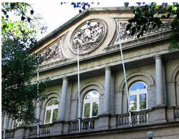
Fachada principal da Santa Casa. Ao centro, o frontão onde estão representadas a Igreja, a medicina e a misericórdia.
